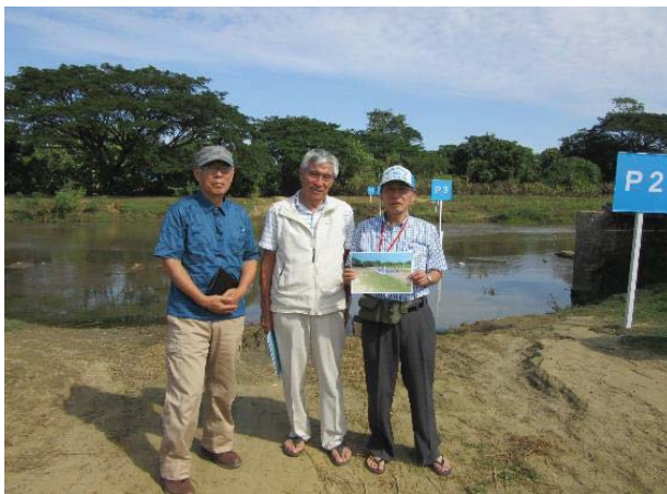
沈下橋の建設現場 私の持っているのが完成予定図
