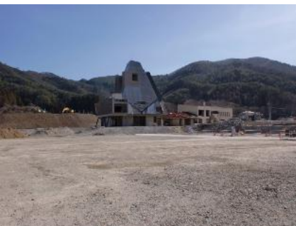
石巻市 雄勝伝統産業会館
