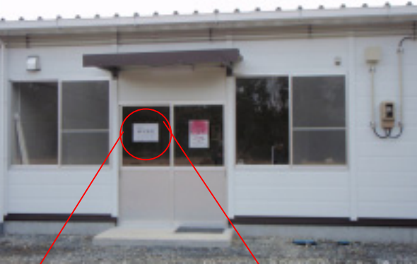
藤中事務所：仮設商店街の端の方にある
